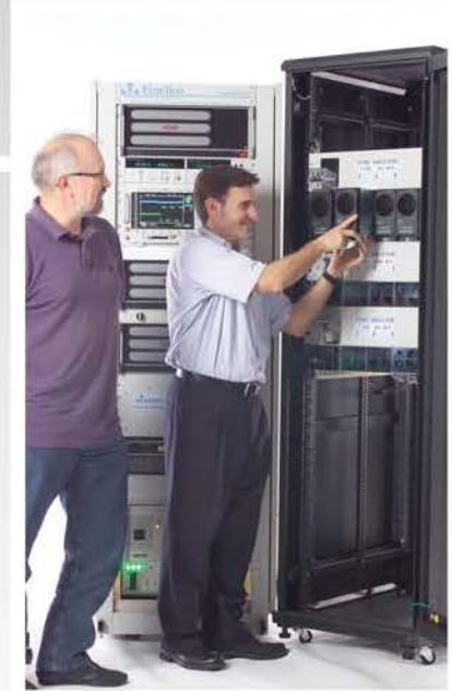
Installing a UUT
